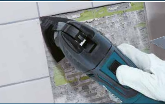
Retirar mortero, adhesivo de azulejo
