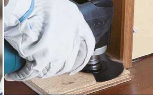
Cortar madera a ras
