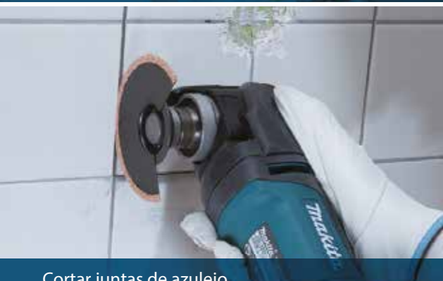
Cortar juntas de azulejo
